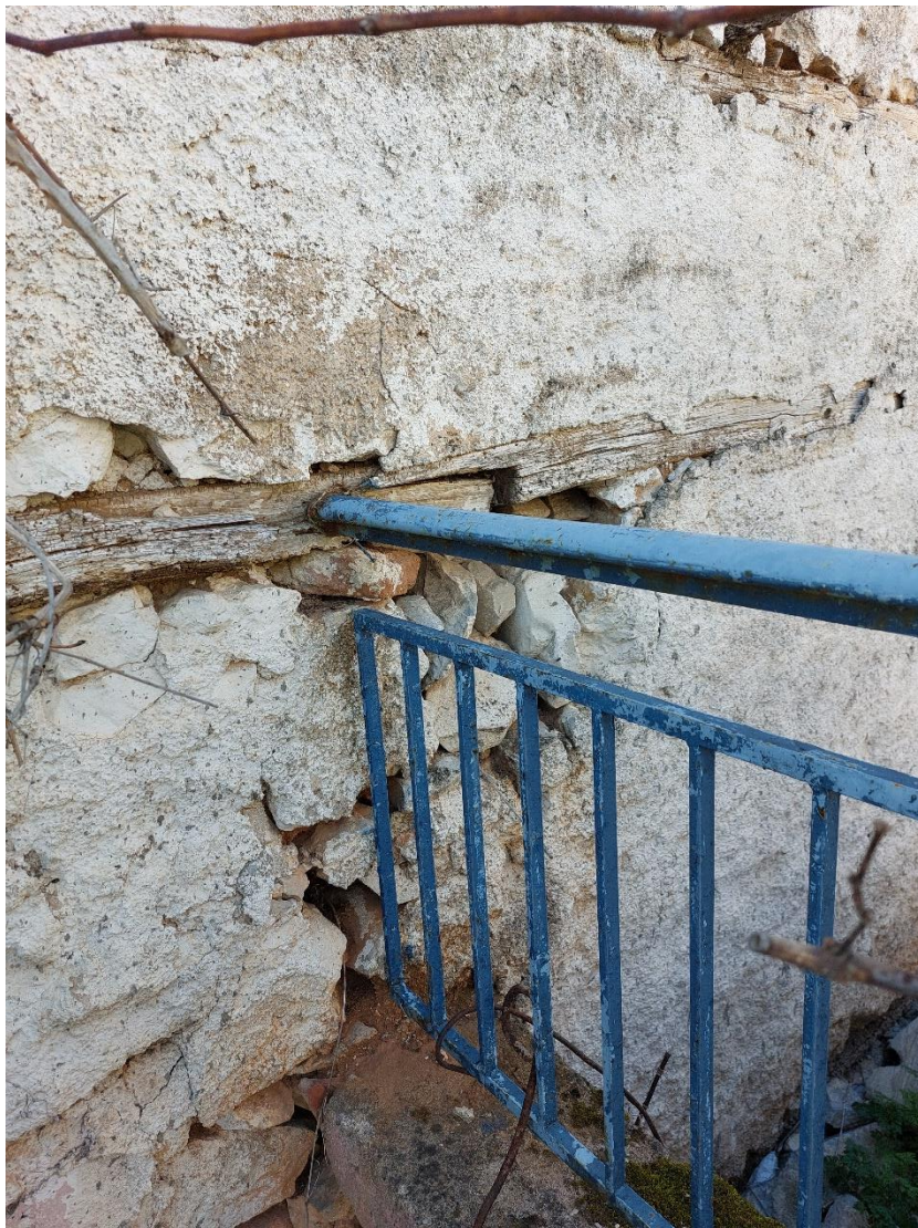
Εικόνα 8. Αστοχία διάτμησης από διαγώνιο εφελκυσμό
