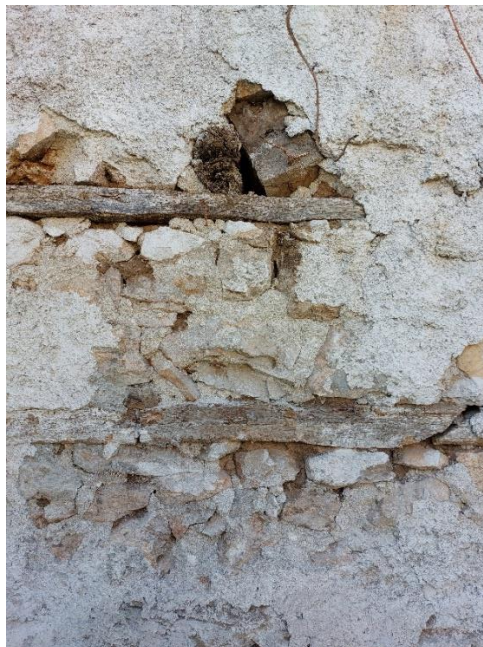
Εικόνα 7. Σύνδεση ξύλινων δοκών δαπέδου με την τοιχοποιία και ξύλινα διαζώματα
