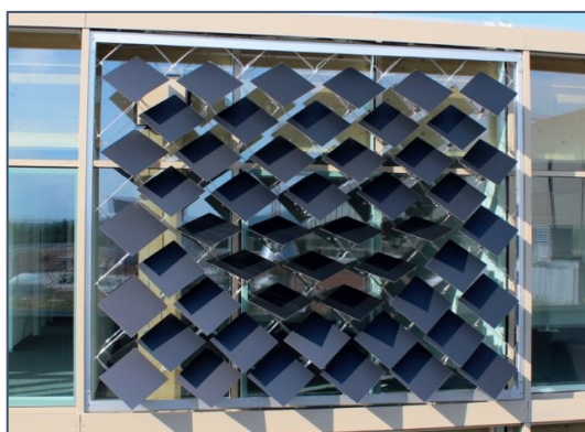
Εικόνα 73. Φωτοβολταϊκά σε πρόσοψη (Bratislav Svetozarevic, και συν., 2016)
