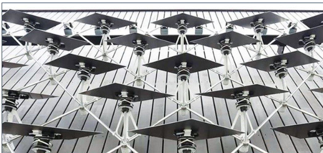
Εικόνα 72. Φωτοβολταϊκά σε πρόσοψη (Bratislav Svetozarevic, και συν., 2016)
