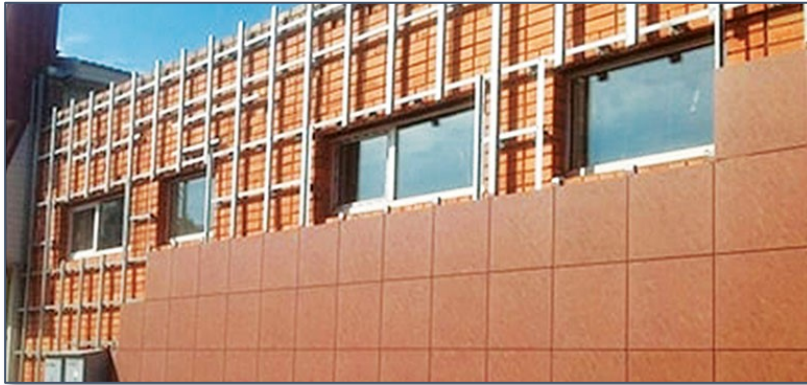
Εικόνα 34. Κατασκευή αεριζόμενης πρόσοψης, Ventilated Façade Layers, (Rai, 2019)
