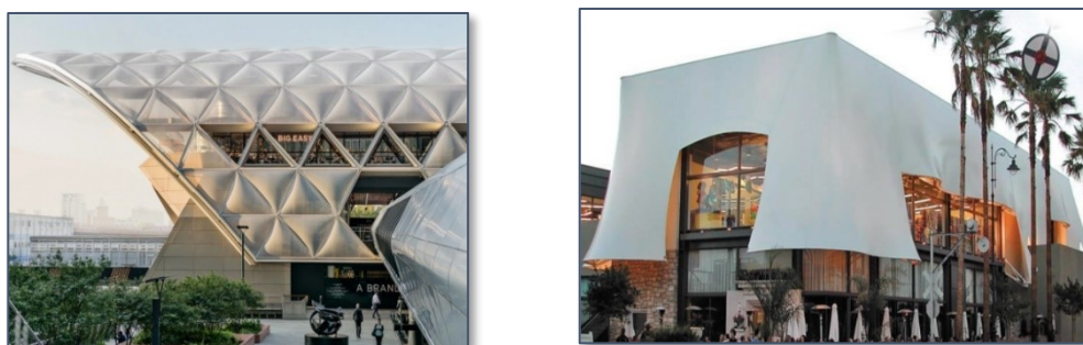
Εικόνα 70. - Εικόνα 71. Προσόψεις με επένδυση εφελκυσμένης μεμβράνης (Tensile fabric , Επίσκεψη: 2022)
