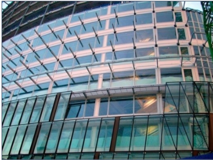
Εικόνα 47. Κατασκευή αεριζόμενης όψης από υαλοπίνακες, (Παπαμανώλης, 2015)
