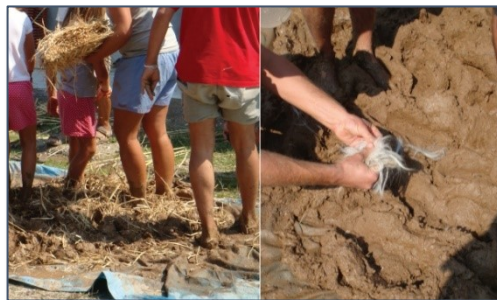
Εικόνα 39. - Εικόνα 40. Υλικά στις χωμάτινες κατασκευές για εγκλωβισμό αέρα (Σπυροπούλου & Τσακαλάκη, 2013)
