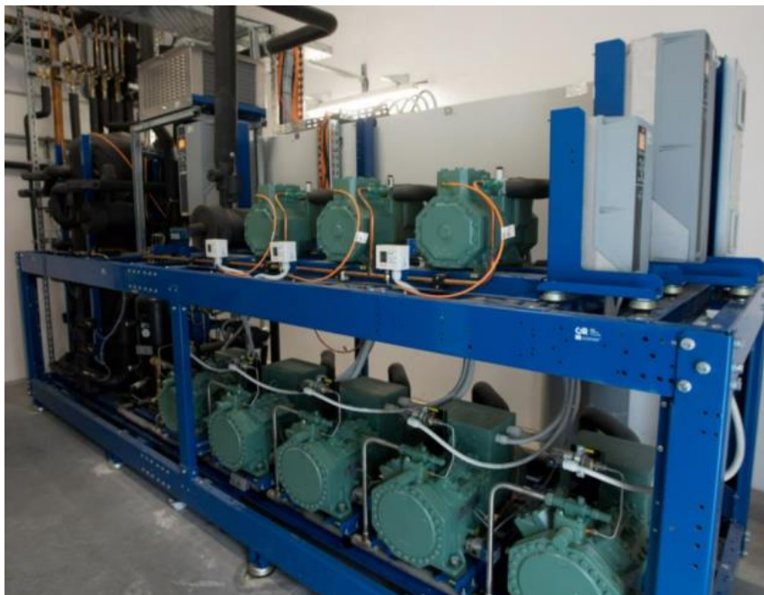
Εικόνα 1. Multi Συντήρησης – κατάψυξης CO 2 με Inverter
