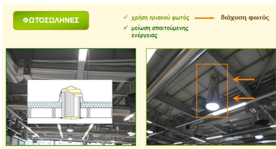
Εικόνα 2. Φωτοσωλήνες σε οροφή από πάνελ
