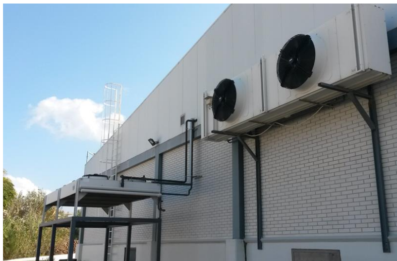
Εικόνα 1. Condenser συντήρησης – κατάψυξης για F-GAS
