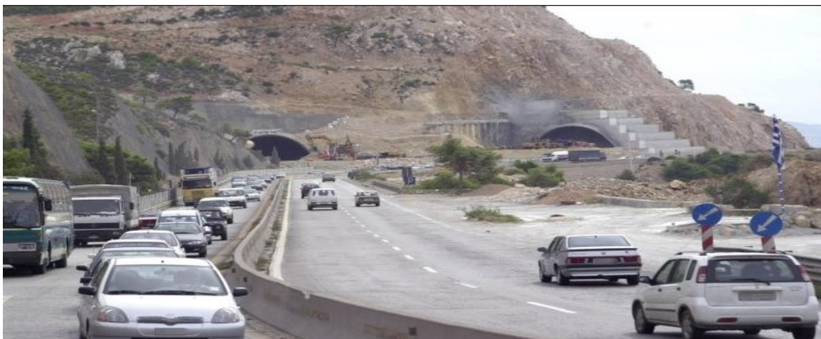
Σχήμα 4. Κυκλοφορία κατά τη διάρκεια εργασιών κατασκευής των σηράγγων στην Κακιά Σκάλα (2003).
