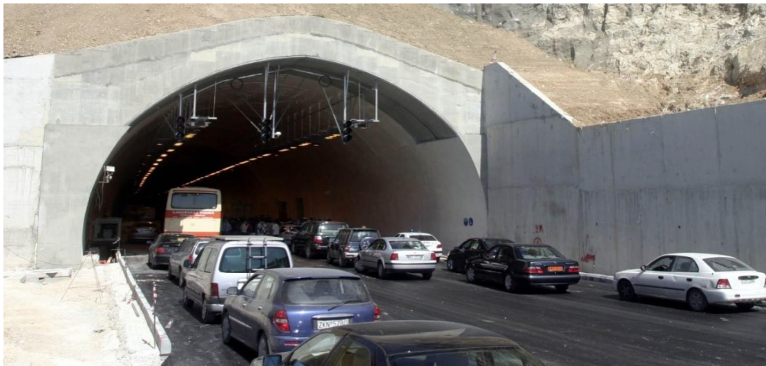
Σχήμα 5. Παράδοση στην κυκλοφορία του Βόρειου κλάδου του συμπλέγματος σήραγγων της Κακιάς Σκάλας, σήραγγα Ευπαλίνος (2004)
