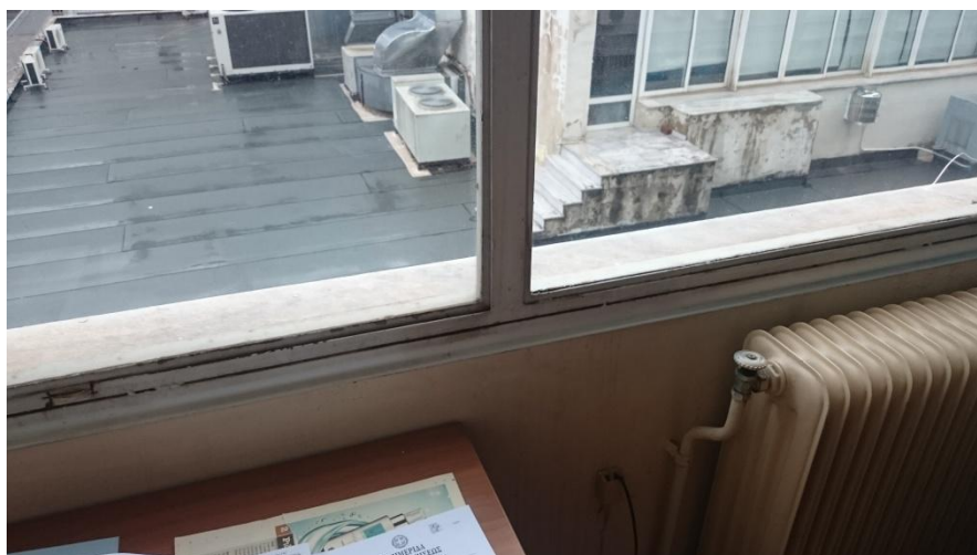
Εικόνα 5.2-1: Κουφώματα Διοικητηρίου με τα κενά στα πλαίσια (φωτογραφία από προσωπικό αρχείο)
