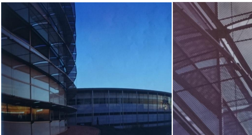
Εικόνα 2.1.2-10: Σκίαστρα και λεπτομέρεια τους σε κτίριο γραφείων, εθν. οδός Αθηνών-Λαμίας (πηγή: Τσιώρα - Παπαιωάννου και άλλοι, 2006)
