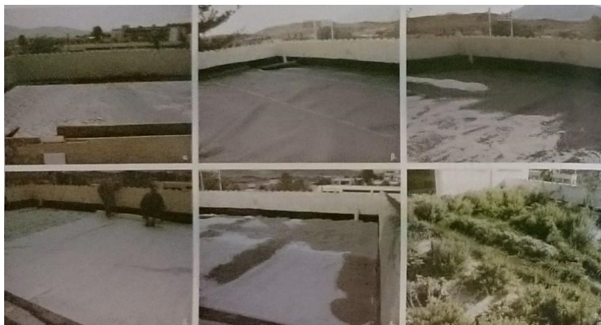
Εικόνα 2.1.2-37: Φωτογραφίες σταδίων κατασκευής και τελικής μορφής φυτεμένου δώματος στο κτίριο γραφείων του ΚΑΠΕ (πηγή: Ανδρουτσόπουλος, 2012)
