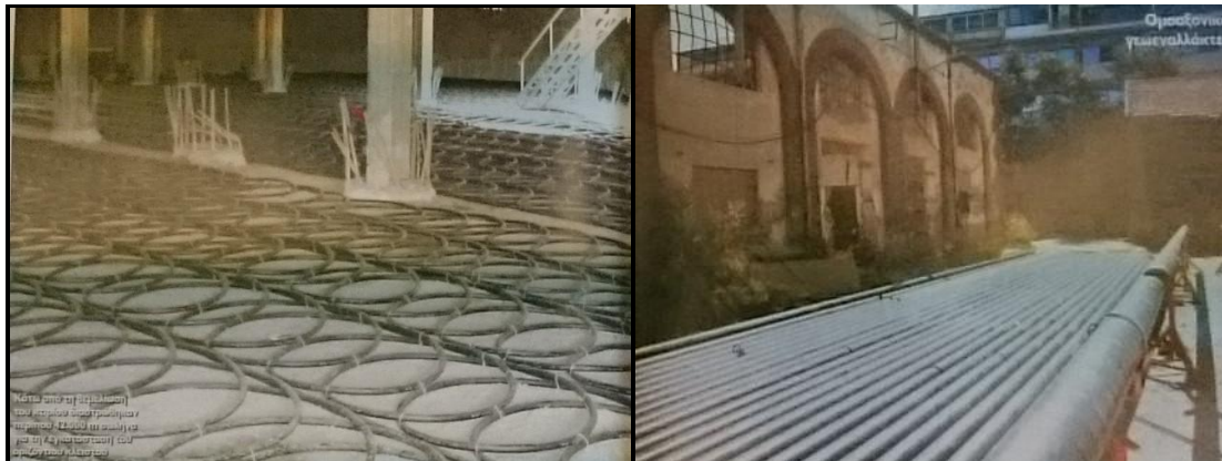
Εικόνα 2.1.2-44: Δίκτυα αγωγών και εναλλακτών στη φάση της κατασκευής στο κτίριο της Περιφέρειας Κεντρικής Μακεδονίας (πηγή: Ψυχούλα, 2014)
