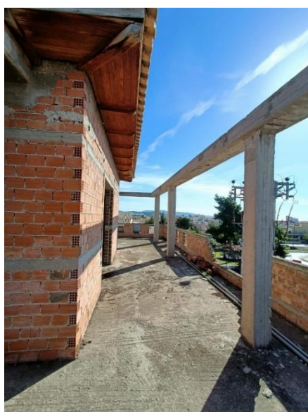
Σχήμα 3.4 Φωτογραφία β' ορόφου.
