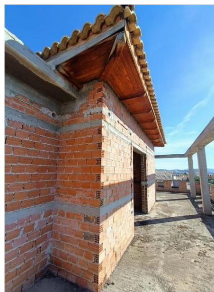
Σχήμα 3.5 Φωτογραφία β' ορόφου.
