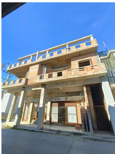
Σχήμα 4.5 Εξωτερική φωτογραφία κτιρίου με όμορο κτίριο.
