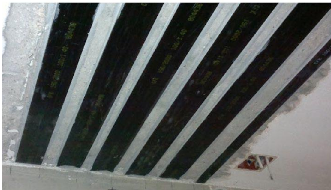
Σχήμα 5.20 Ενίσχυση Πλάκας με ανθρακοελάσματα.
