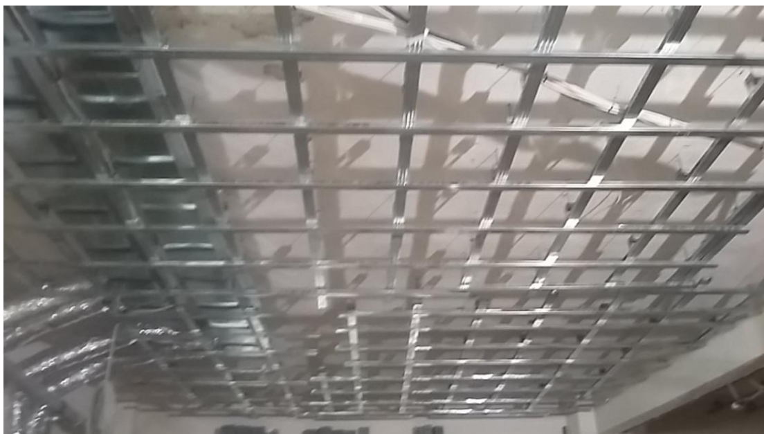
Εικόνα 3.4 Οι μεταλλικές βάσεις στήριξης τοποθετημένες σταυρωτά
