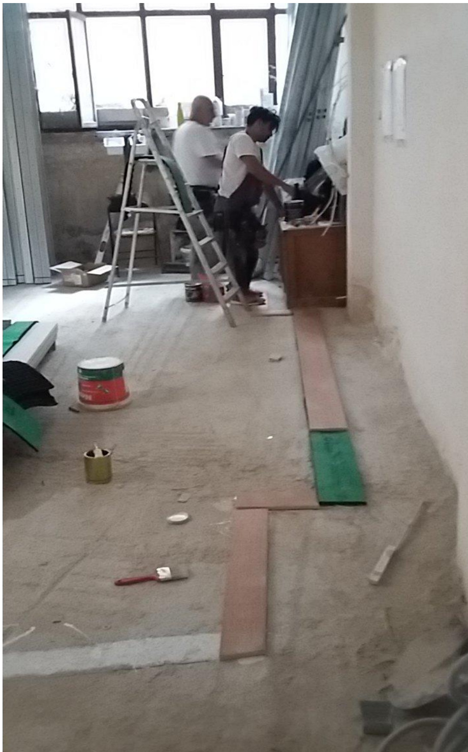
Εικόνα 3.7 Οι οδηγοί με το κόντρα πλακέ και το αντικραδασμικό υπόστρωμα όπου θα πατήσουν τα τοιχία
