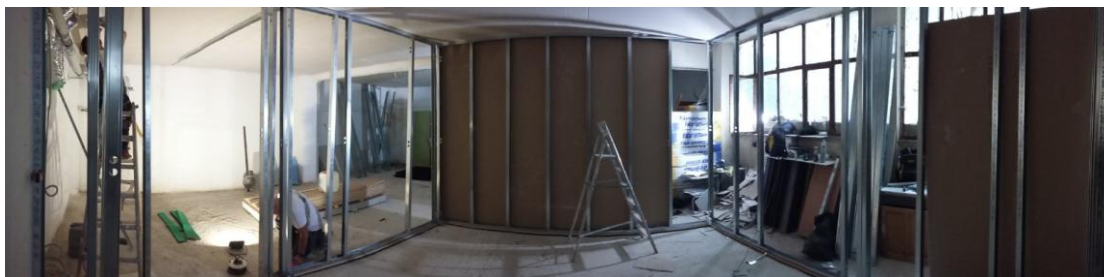
Εικόνα 3.8 Η κατασκευή των τοιχίων
