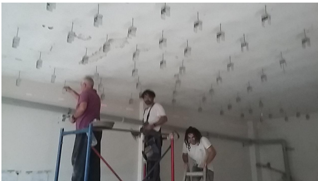
Εικόνα 3.3 Οι αντικραδασμικές αναρτήσεις οροφής τοποθετημένες σε τριγωνική μορφή ανά τετραγωνικό
