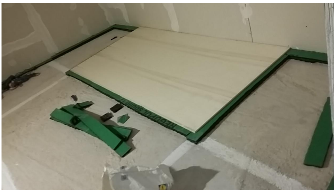
Εικόνα 3.9 Η κατασκευή του πλωτού πατώματος
