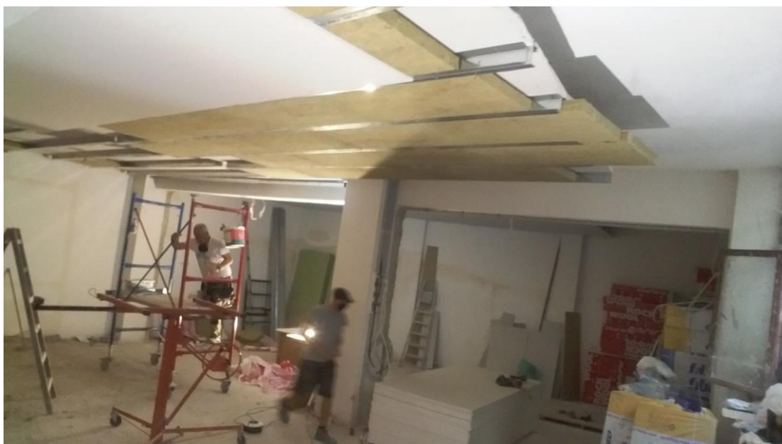
Εικόνα 3.5 Οι γυψοσανίδες και ο πετροβάμβακας οροφής
