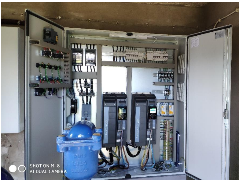
Εικόνα 27. Ερμάριο εξοπλισμού ΤΣΕ στο ηλεκτροστάσιο
