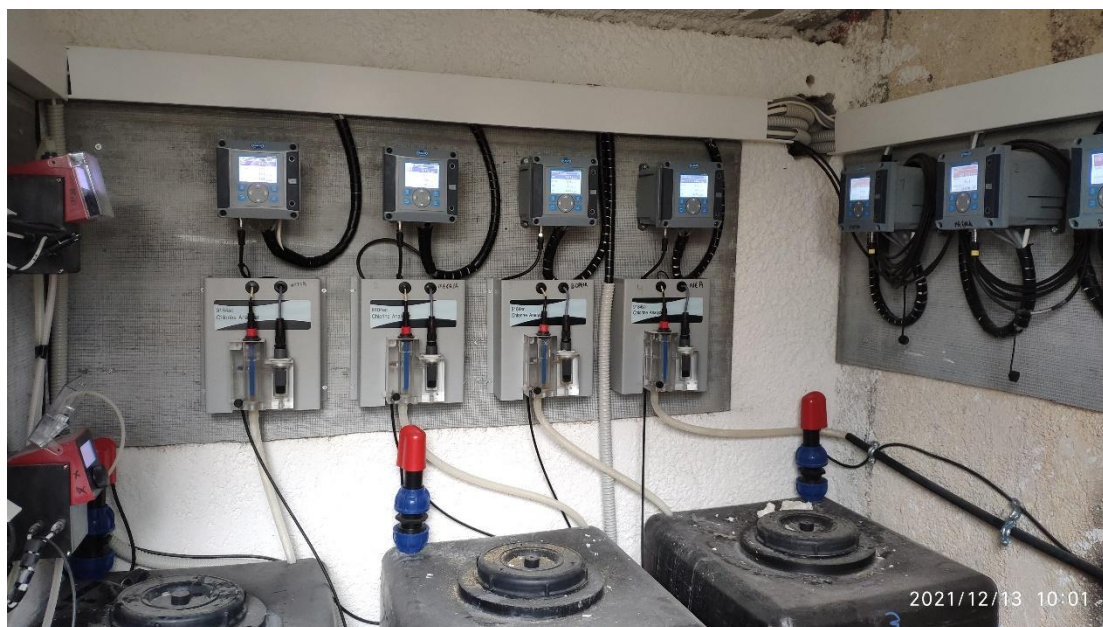
Εικόνα 30. Αισθητήρια ποιοτικών παραμέτρων θολότητας, αγωγιμότητας, pH και υπολειμματικού χλωρίου στις γεωτρήσεις Εύηνου
