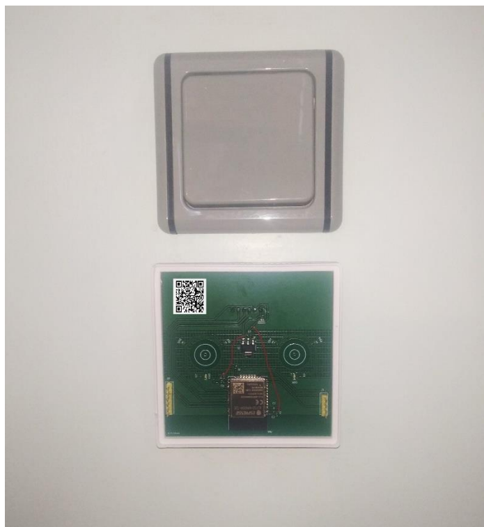
Εικόνα 7.7.1 Εγκατάσταση δοκιμαστικού διακόπτη
