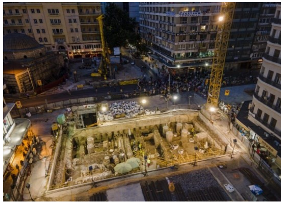
Εικόνα 27: Πλατεία Καπνεργάτη (έργα Μετρό)
