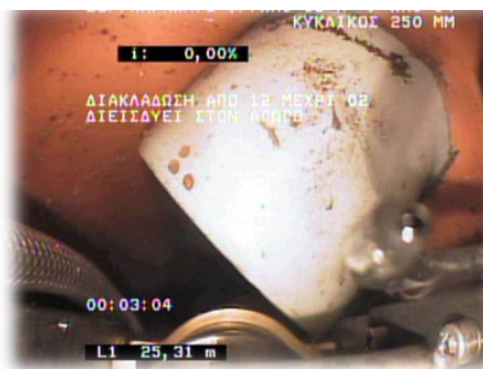
Σχήμα 39 Επισκευή – κοπή σύνδεσης με Robot CCTV
