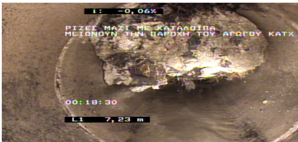
Σχήμα 18 Εικόνα Τηλεοπτικής Επιθεώρησης 2
