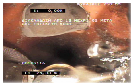
Σχήμα 39 Επισκευή – κοπή σύνδεσης με Robot CCTV
