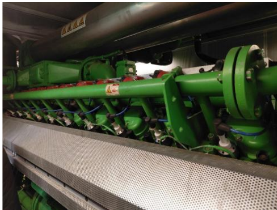
Εικόνα 23 – (α) Μηχανή Εσωτερικής Καύσεως (MEK) 999 kWel Jenbacher, (β) Γεννήτρια Jenbacher (προσωπικό αρχείο, 06/04/2026)
