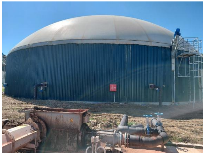
Εικόνα 6 - Βιοαντιδραστήρας χώνευσης (προσωπικό αρχείο, 06/04/2026)
