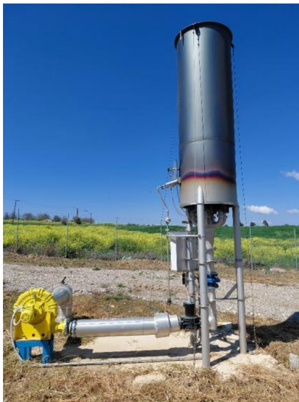
Εικόνα 17 - Πυρσός καύσης βιοαέριου (προσωπικό αρχείο, 06/04/2026)
