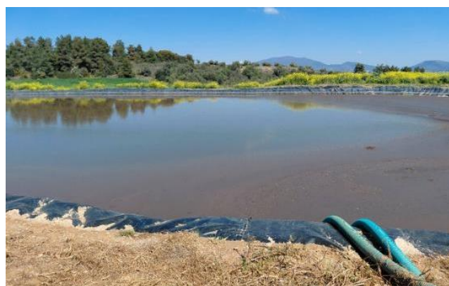
Εικόνα 12 - Άποψη της μεγάλης λιμνοδεξαμενής (2) αποθήκευσης υγρού χωνεμένου υπολείμματος (προσωπικό αρχείο, 06/04/2026)
