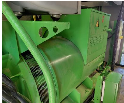
Εικόνα 23 – (α) Μηχανή Εσωτερικής Καύσεως (MEK) 999 kWel Jenbacher, (β) Γεννήτρια Jenbacher (προσωπικό αρχείο, 06/04/2026)
