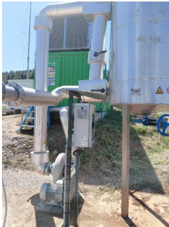
Εικόνα 22 - Μεταφορά του βιοαερίου στο φίλτρο ενεργού άνθρακα μετά από τη ξήρανσή του (προσωπικό αρχείο, 06/04/2026)
