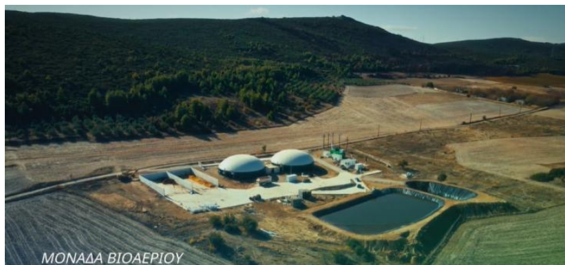
Εικόνα 2 - Μονάδα παραγωγής βιοαερίου στην Τανάγρα Βοιωτίας (PK ENERGY, 2026)
