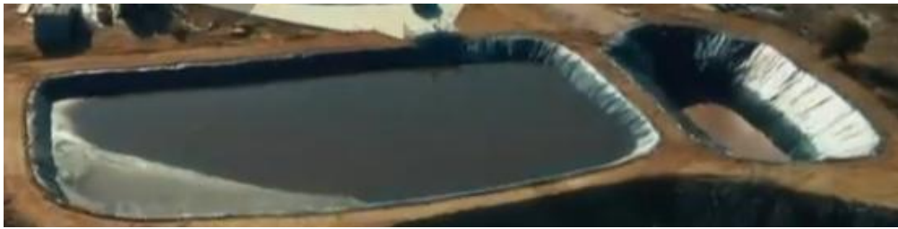
Εικόνα 13 - Λιμνοδεξαμενές 1 και 2 αποθήκευσης υγρού χωνεμένου υπολείμματος (PK ENERGY, 2026)
