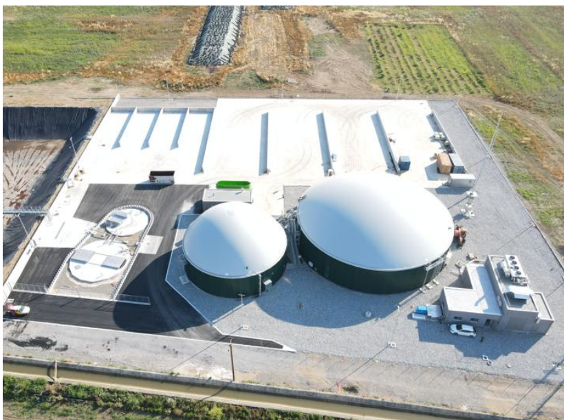
Εικόνα 3: Αεροφωτογραφία μονάδας αναερόβιας χώνευσης της ΜΑΚΙΟΣ Α.Ε. κατά την περίοδο ολοκλήρωσης της κατασκευής.
