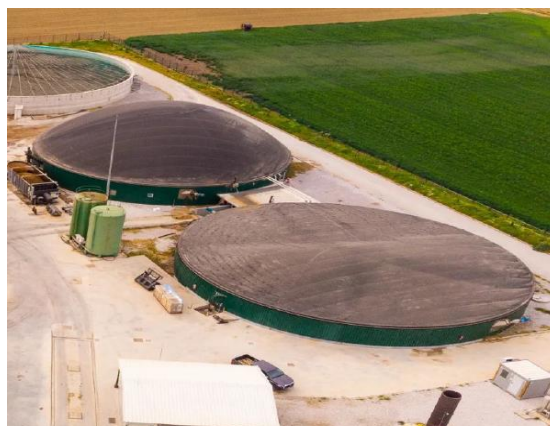
Εικόνα 6: Αεροφωτογραφία Μονάδας Αναερόβιας Χώνευσης «ΒΙΟΑΕΡΙΟ ΛΑΓΚΑΔΑ Α.Ε.» (Μυλωνάς, 2025)
