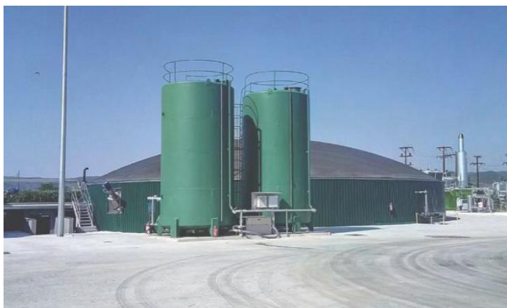
Εικόνα 5: Δεξαμενή πρωτογενούς χώνευσης (main digester) Μονάδας Αναερόβιας Χώνευσης «ΒΙΟΑΕΡΙΟ ΛΑΓΚΑΔΑ Α.Ε.» (Μυλωνάς, 2025)
