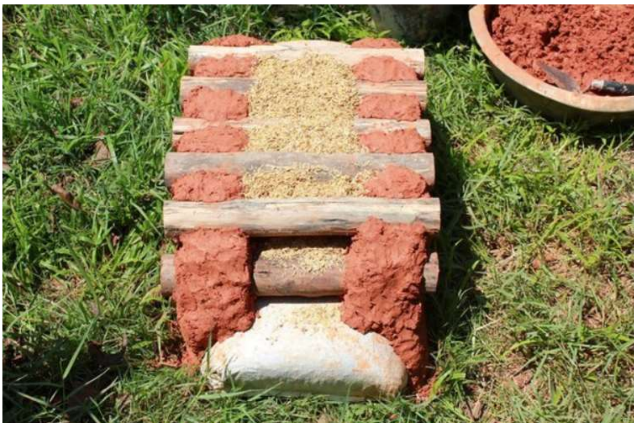
Σχήμα 3.6: Ο κανόνας του 1/3 στην τεχνική Cobwood (Πηγή: http://www.goodshomedesign.com/cordwood-log-cabins/ , 2018)
