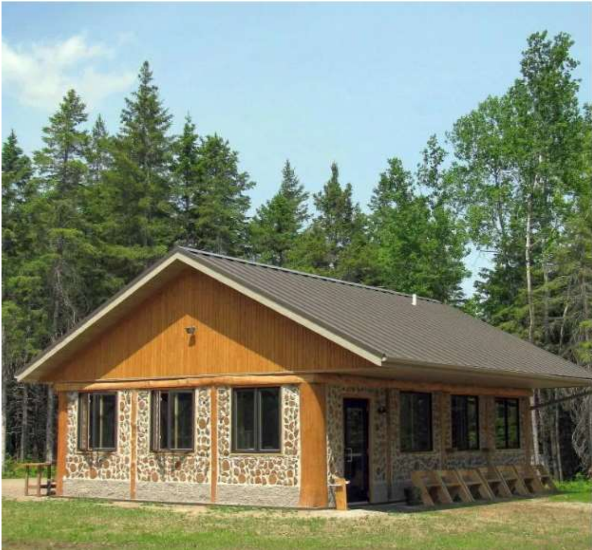
Σχήμα 3.8: Επένδυση εξωτερικά με πέτρα σε χαμηλό ύψος από το έδαφος για την προστασία από την ανιούσα υγρασία (άμεση και έμμεση) (Πηγή: https://cordwoodconstruction.wordpress.com/ , 2018)
