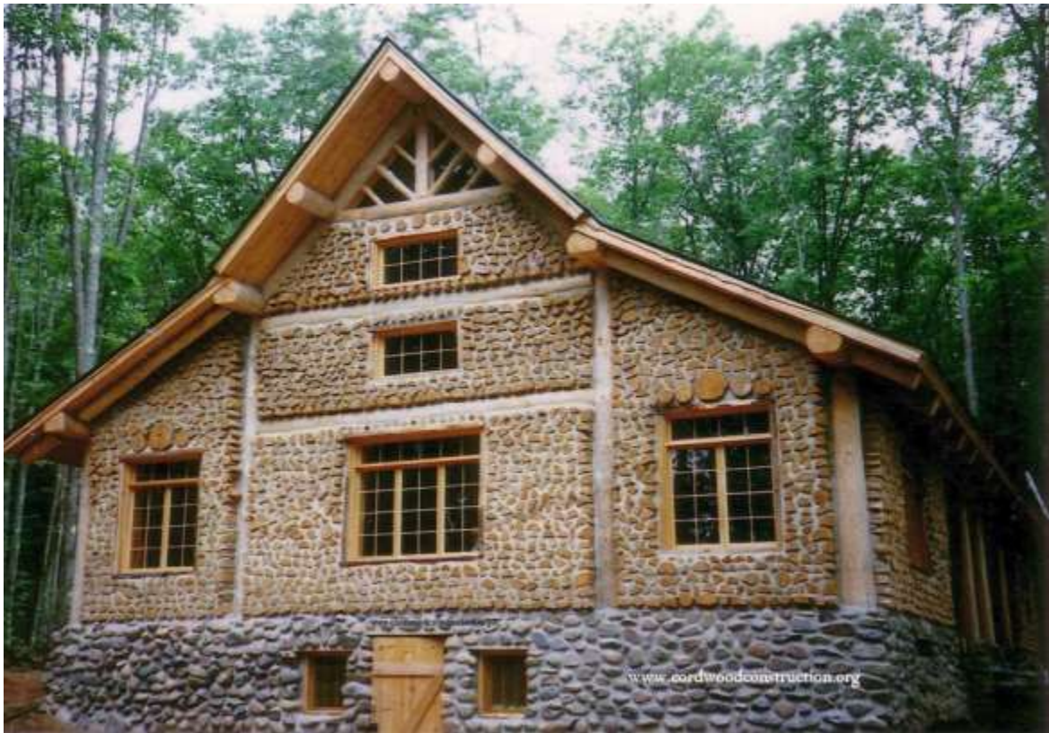
Σχήμα 3.2: Ξύλινη διώροφη κατοικία κατασκευασμένη το 1995 στο Minocqua του Northern Wisconsin, ΗΠΑ με την τεχνική του cordwood ως ανωδομή πετρόχτιστου υπογείου (Πηγή: https://cordwoodconstruction.wordpress.com/2016/10/09/cordwood-lodge/ , 2018)
