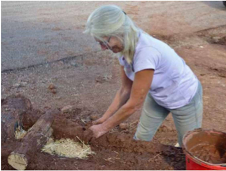
Σχήμα 3.5: Κτίσιμο τοιχοποιίας πλήρωσης με την τεχνική Cobwood και λεπτομέρεια αυτής (Πηγή: Roy, 2016)
