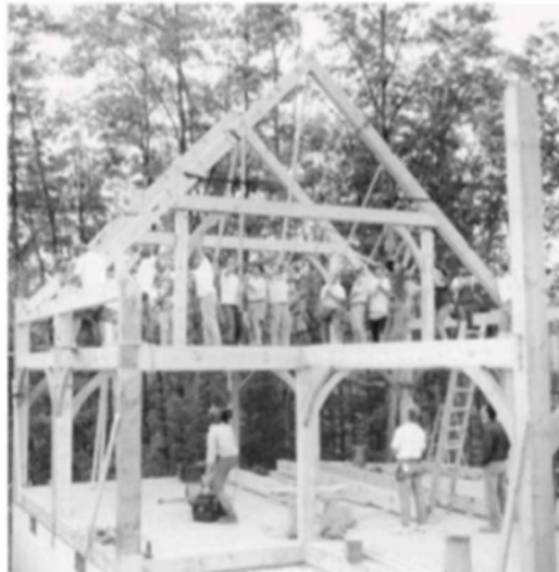
Σχήμα 3.3: Ξύλινος φέρον οργανισμός διώροφης κατοικίας κατασκευασμένος από μαθητές του Fox Maple School of Traditional Building στο Brownfield του Maine, ΗΠΑ στα πλαίσια εργαστηρίου (Πηγή: Roy, 2004)
