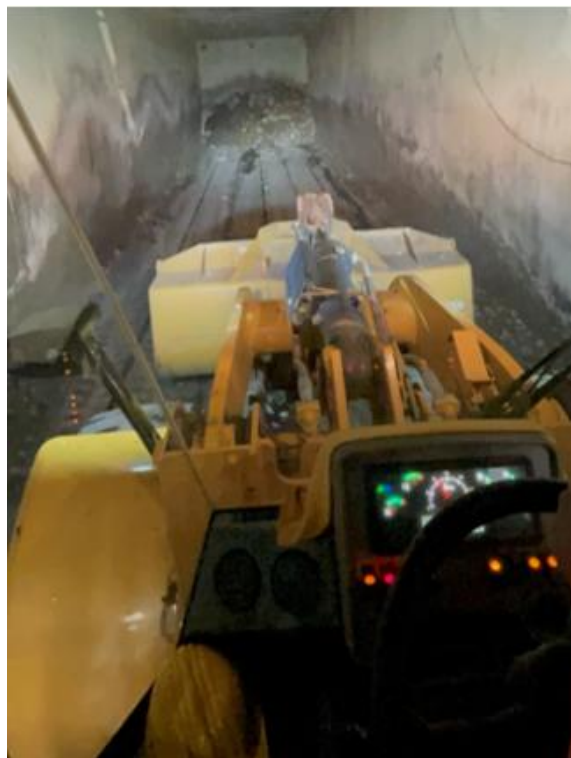
Εικόνα 5.2.8: Πλήρωση κελιού αναερόβιας χώνευσης.
