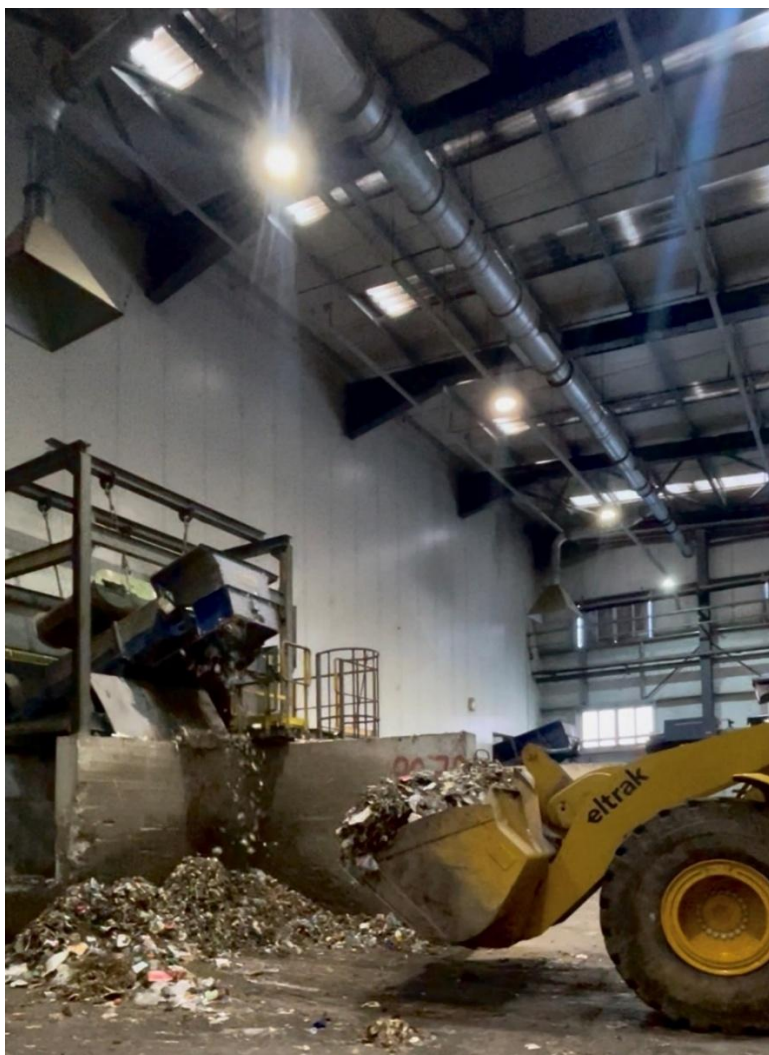
Εικόνα 5.2.2: Παραλαβή από ελαστιχοφόρο φορτωτή κλάσματος 20-70 mm προς πλήρωση κελιών αναερόβιας χώνευσης.
