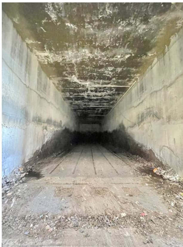
Εικόνα 5.2.5: Εσωτερικό κελιού ξηρής αναερόβιας χώνευσης.
