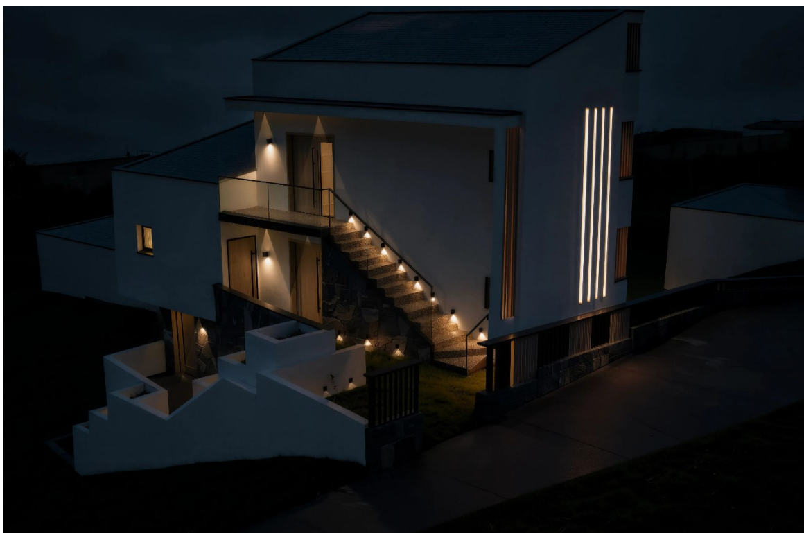
Εικόνα 60 Συνολικός φωτισμός (downlights) της Ν/Α και Ν/Δ όψης κατά τις βραδινές ώρες που ενεργοποιούνται με αισθητήρες κίνησης
