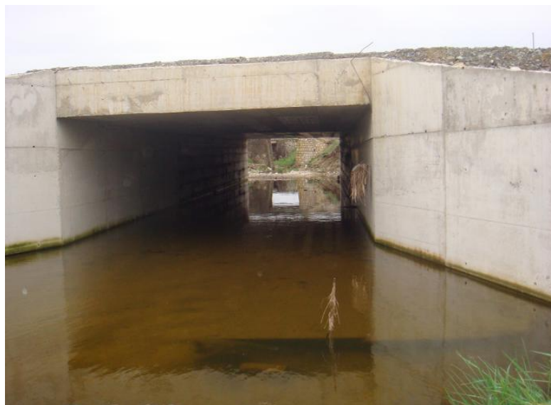
Εικόνα 30 Κιβωτοειδής οχετός μεγάλων διαστάσεων στην ΝΣΓΥΤ (6Χ4) όπου παρατηρείται διαρκές λίκνισμα του νερού.
