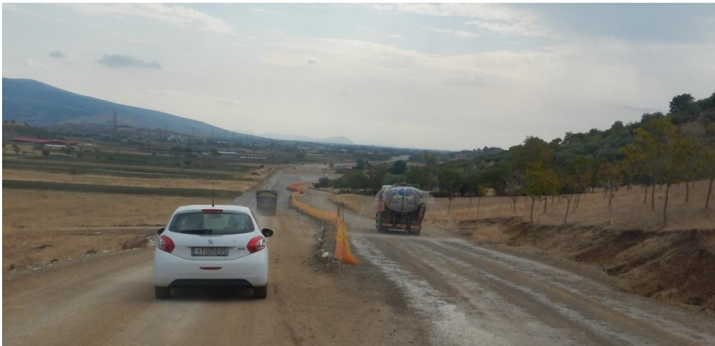
Εικόνα 43 Διαβροχή χωμάτινης εργοταξιακής οδού στην περιοχή της Ράξας Τρικάλων.
