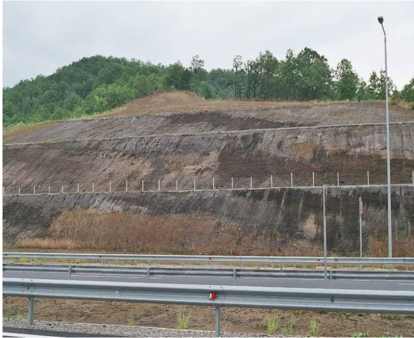
Εικόνα 38 Τοποθέτηση φράκτη σε ενδιάμεση μπαγγίνα μεγάλων ορυγμάτων – Εγγατία οδός
