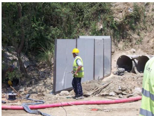
Εικόνα 7. Τοποθέτηση κινητών ηχοπετασμάτων στην περιοχή κατασκευής της γέφυρας του π. Σπερχειού.
