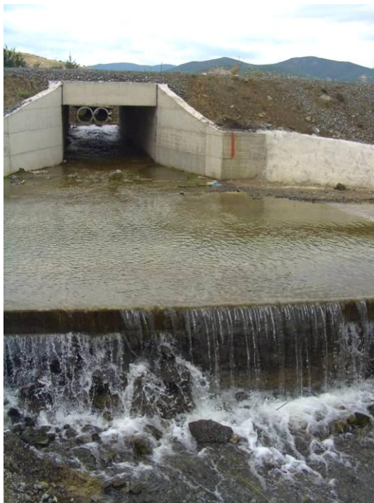
Εικόνα 34 Κατασκευασμένος οχετός της ΝΣΓΥΤ χωρίς διαμόρφωση εισόδου
