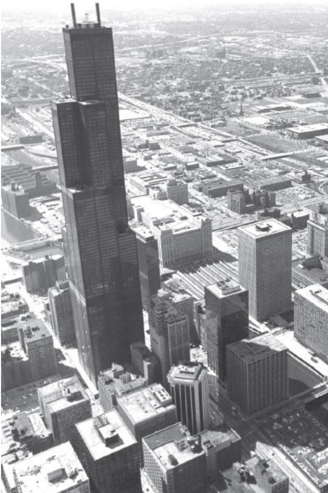
Εικόνα 2.13: Σύστημα Δεσμοποιημένου Σωληνοειδούς, κτίριο Willis Towers
