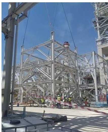
Εικόνα 6.3.1: Αποψη του έργου Γ΄
