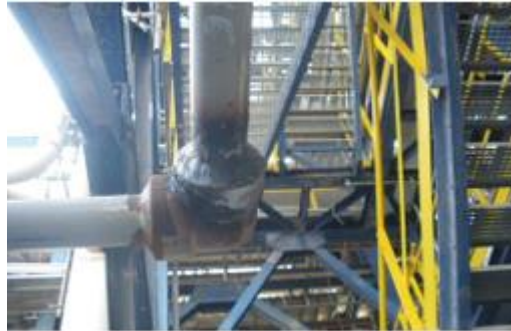
Εικόνα 3.2.2: Socket weld
