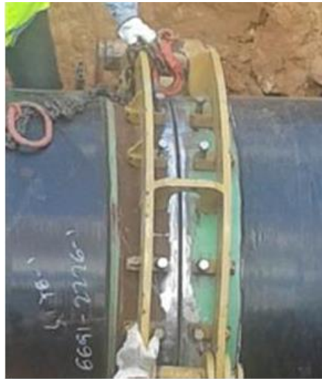
Εικόνα 6.2.5: εργασίες μονταρίσματος (fit up) του αγωγού στο χαντάκι.
