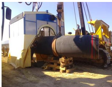
Εικόνα 6.2.1: Στέγαστρο συγκολλήσεων στον ΤΑΠ
