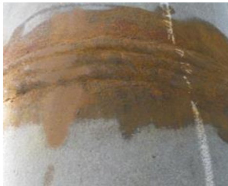
Εικόνα 3.2.1.1: Συγκολλήσεις πεδίου
