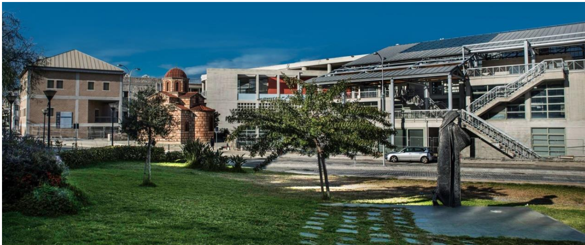
Εικόνα 1: Απόψεις του κεντρικού κτιρίου του Πολιτιστικού και Συνεδριακού Κέντρου Ηρακλείου ( www.cccc.gr )
