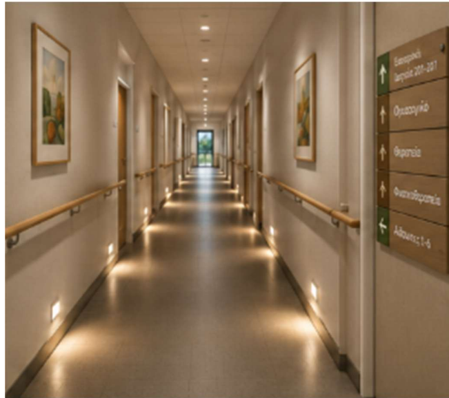
Εικόνα 21: Φωτισμός καθοδήγησης κοντά στο δάπεδο και φωτισμός ανάδειξης σημάνσεων για σαφήνεια και κατανόηση διαδρομών.
