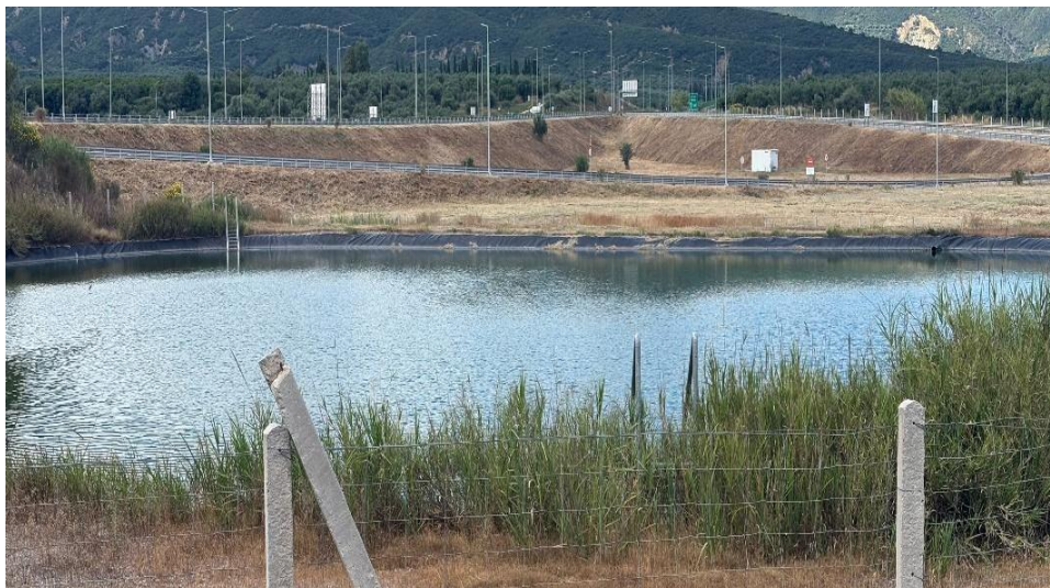
Εικόνα 4-9 Ανοιχτή στεγανή δεξαμενή επεξεργασμένων λυμάτων.
