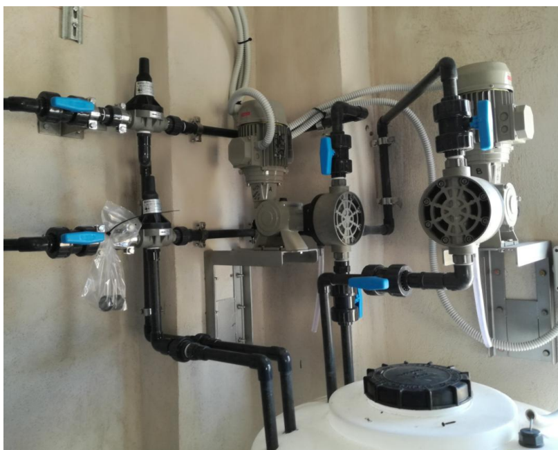
Εικόνα 4-13 Διάταξη συστήματος καθαρισμού βιομεμβρανών
