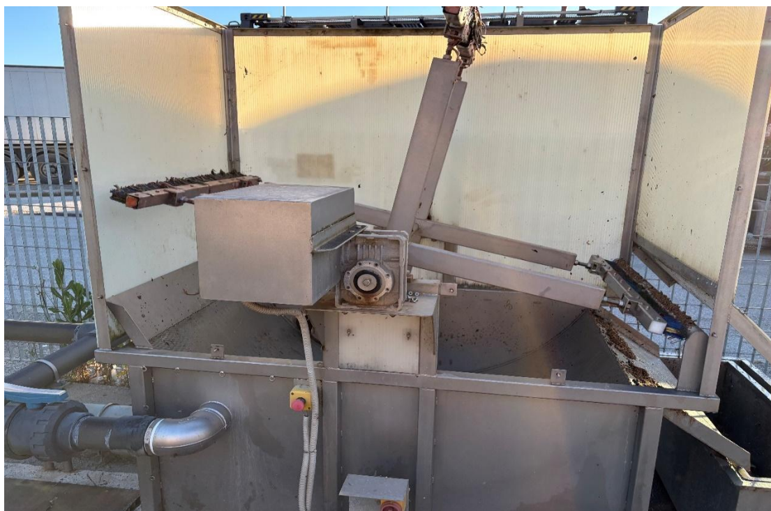
Εικόνα 4-2 Αυτοκαθαριζόμενη εσχάρωση
