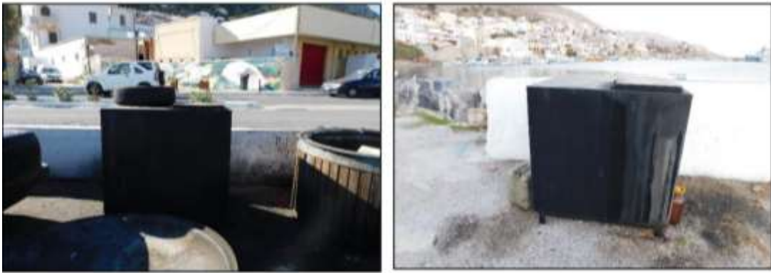
Εικόνα 3. Δεξαμενές αποθήκευσης ΑΛΕ στον λιμένα Καλύμνου.
