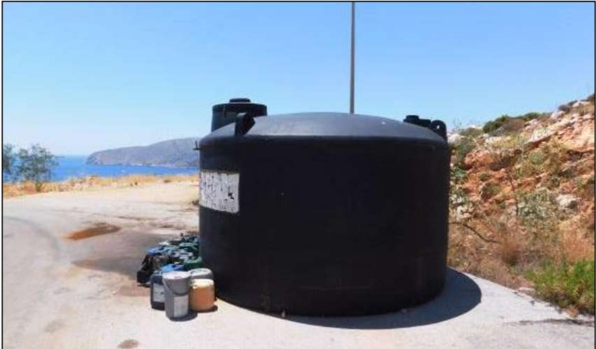
Εικόνα 2. Η δεξαμενή αποθήκευσης πετρελαιοειδών αποβλήτων στον χώρο του Βιολογικού.
