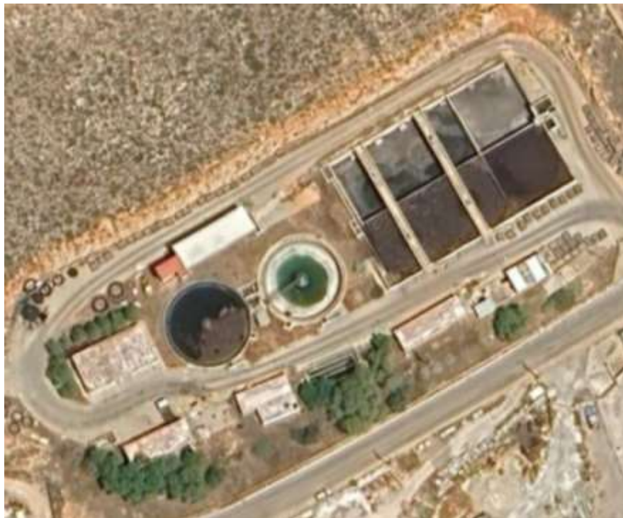
Εικόνα 4. Ο Βιολογικός Καθαρισμός Καλύμνου
