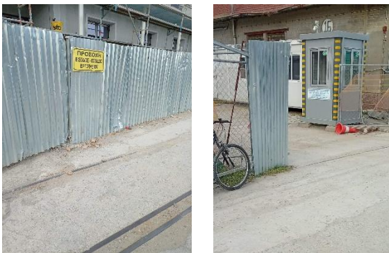
Εικόνες 9-10: Περίφραξη και ελεγχόμενη είσοδος εργοταξίου
