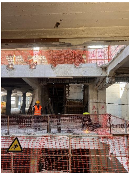
Εικόνες 11-15: Προστατευτικό κιγκλίδωμα, δίκτυ προστασίας και σημάνσεις ασφαλείας
