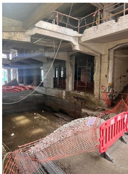
Εικόνες 11-15: Προστατευτικό κιγκλίδωμα, δίκτυ προστασίας και σημάνσεις ασφαλείας
