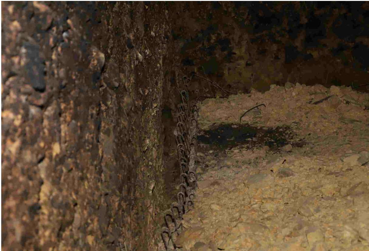
Εικόνα 6.27 Αναμονές για τη σύνδεση του δαπέδου με τα τοιχία σε ημιτελές καταφύγιο του οχυρού Ρούπελ (Πηγή: Προσωπικό αρχείο)
