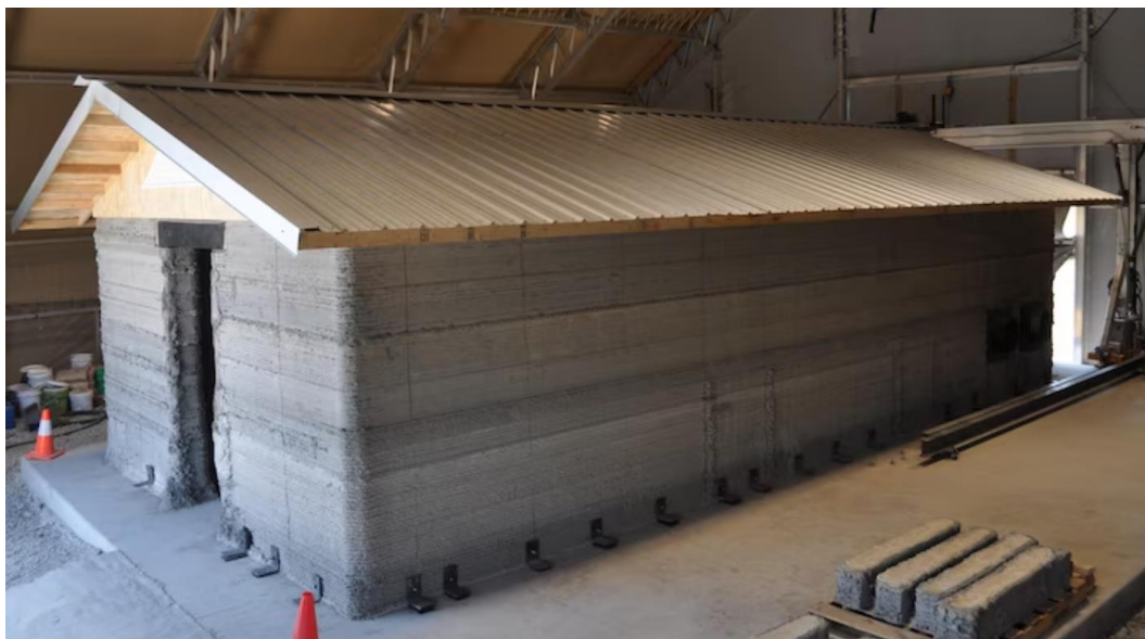
Εικόνα 5.3 Κατασκευή τρισδιάστατου εκτυπωμένου στρατώνα (Πηγή: https://www.erdc.usace.army.mil )
