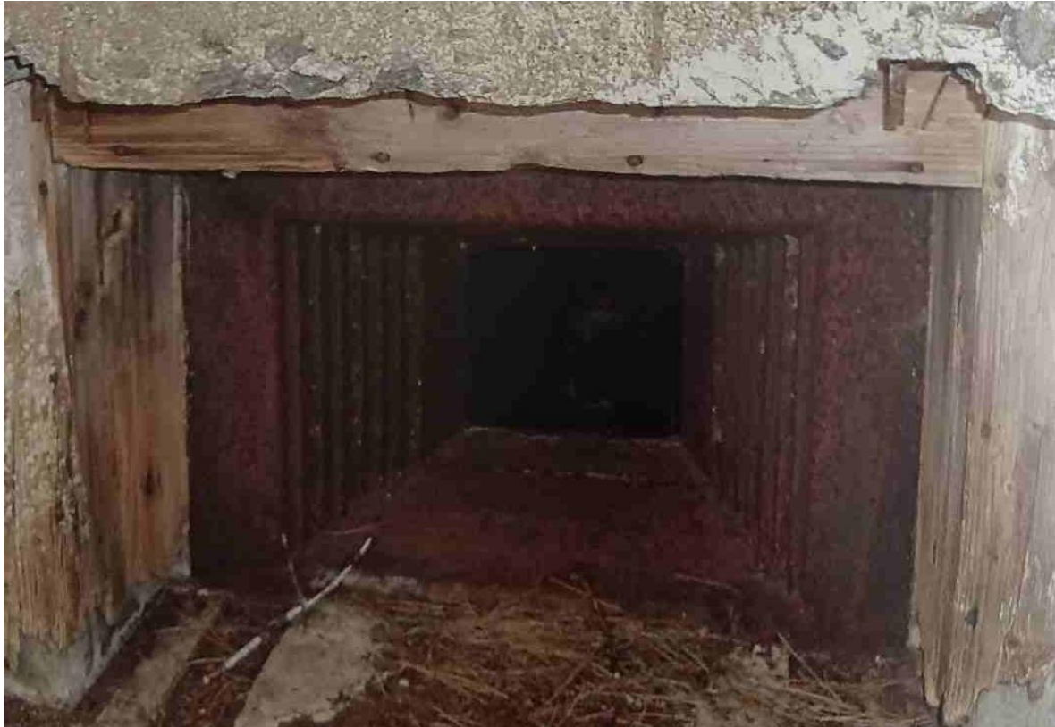
Εικόνα 6.5 Φάτνωμα πολυβολείου όπου διακρίνεται η ξύλινη και η χαλύβδινη επένδυση (Πηγή: Γκιρμπάτσης, 2018)
