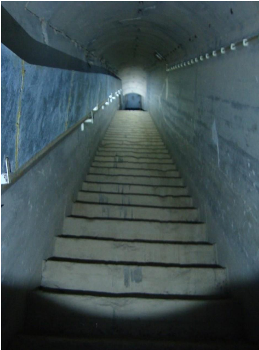
Εικόνα 6.31 Απότομη σκάλα από οπλισμένο σκυρόδεμα που οδηγεί σε παρατηρητήριο (Πηγή: www.metaxasline.org )
