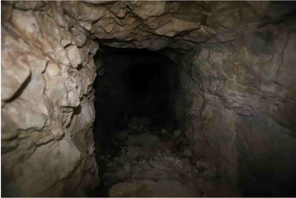
Εικόνα 6.25 Ημιτελής στοά στο οχυρό Λίσσε, κατασκευασμένη με τη μέθοδο της εξόρυξης (Πηγή: Προσωπικό αρχείο)
