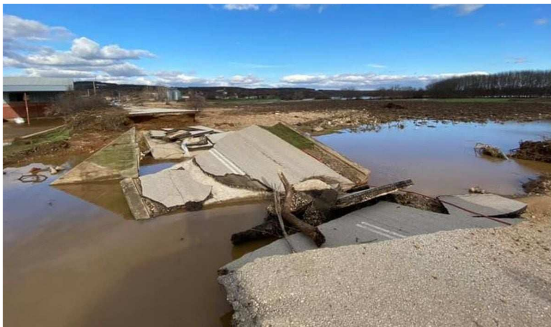
Εικόνα 1 Καταστροφή μικρής γέφυρας από την πλημμύρα του ποταμού στον Έβρο (2021) (Πηγή: newsbreak.gr )
