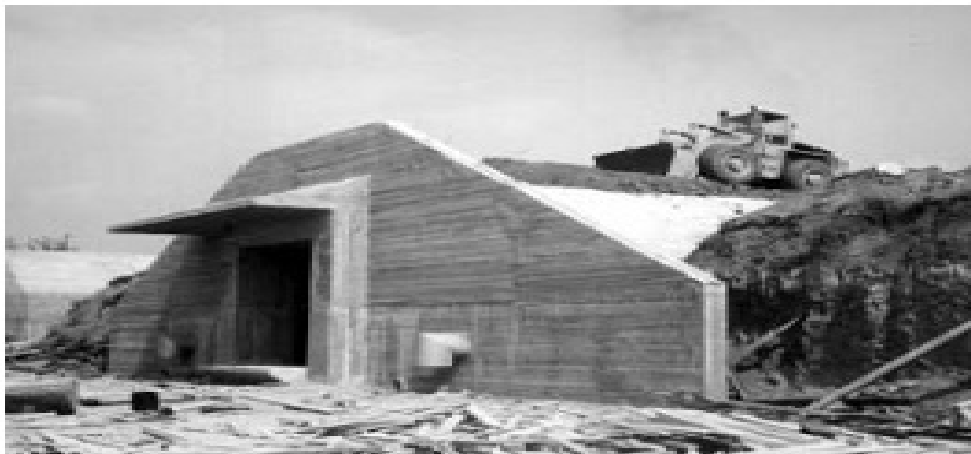
Εικόνα 33. Τυποποιημένος χώρος αποθήκευσης πυρομαχικών τύπου Igloo. (Πηγή: NATO 2001, 55)
