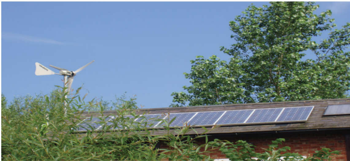
Εικόνα 23. Μικρή αστική ανεμογεννήτρια ισχύος 1 kW σε συνδυασμό με φωτοβολταϊκά πλαίσια. (Πηγή: Encraft Ltd, μέσω Roaf et al 2007, 269)
