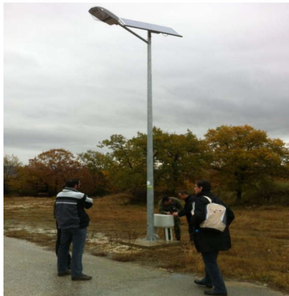
Εικόνα 41. Αυτόνομο εξωτερικό φωτιστικό σώμα στο στρατόπεδο «Υπ. Τριανταφυλλίδη» στην Ξάνθη. (Πηγή : ΥΠΕΘΑ 2016)
