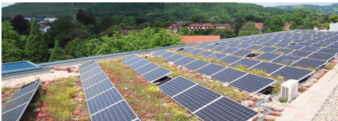
Εικόνα 15. Παράδειγμα φυτεμένου δώματος (βλάστηση ελάχιστης φροντίδας (εκτατικού τύπου) σε συνδυασμό με χρήση ΑΠΕ (φωτοβολταϊκά στοιχεία). (Πηγή: Green Roof Technology, χ.η)
