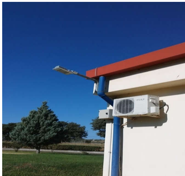
Εικόνα 19. Επιτοίχιο εξωτερικό φωτιστικό LED σε κτίριο στρατοπέδου βάσεως στην Αλεξανδρούπολη. (Πηγή: Φωτογραφία του ιδίου, 2018)
