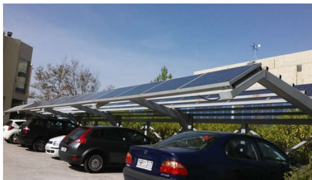
Εικόνα 21. Χρήση σταθερών φωτοβολταϊκών πλαισίων σε μεταλλικό στέγαστρο. (Πηγή: Φωτογραφία του ιδίου, 2016).
