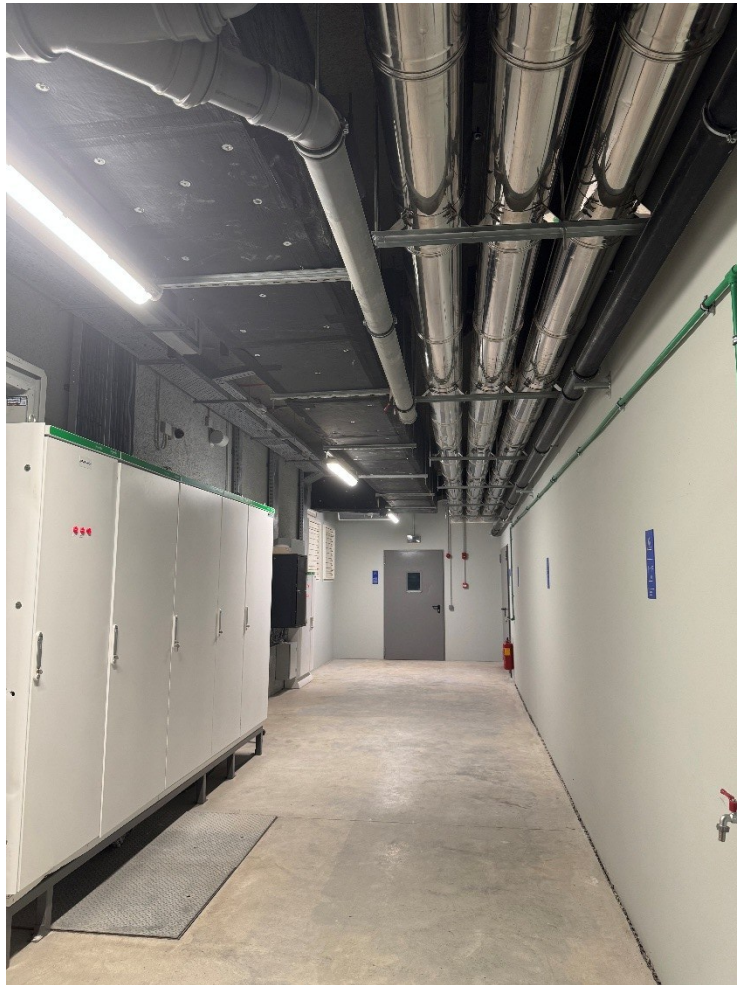
Εικόνα 5.7: Πραγματική αποτύπωση του σημείου Α στο Β' υπόγειο κατά τη φάση εγκατάστασης των Η/Μ δικτύων. Πηγή: φωτογραφικό αρχείο έργου / ιδία λήψη, ιδία επεξεργασία.
