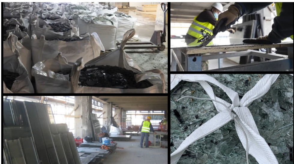
Εικόνα 2.7: Διαλογή του γυαλιού των παλαιών υαλοπινάκων της όψης πριν από την ανακύκλωση. Πηγή: Solar Control Glass (2026), ιδία επεξεργασία.
