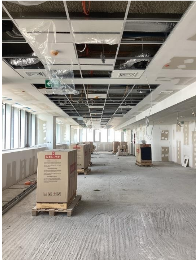
Εικόνα 5.14: Πραγματική άποψη της ψευδοροφής του τυπικού ορόφου, στην περιοχή ελέγχου Β. Πηγή: φωτογραφικό/τεχνικό αρχείο έργου, ίδια επεξεργασία.
