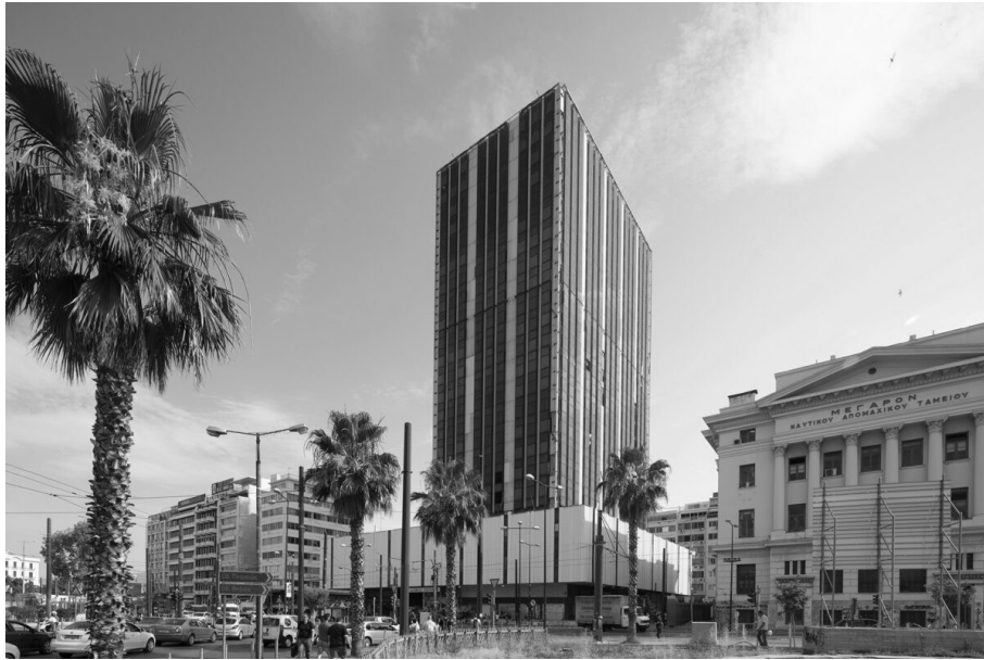
Εικόνα 2.5: Ο Πύργος του Πειραιά με την παλιά του όψη. Πηγή: φωτογραφικό/τεχνικό αρχείο έργου, ιδία επεξεργασία.
