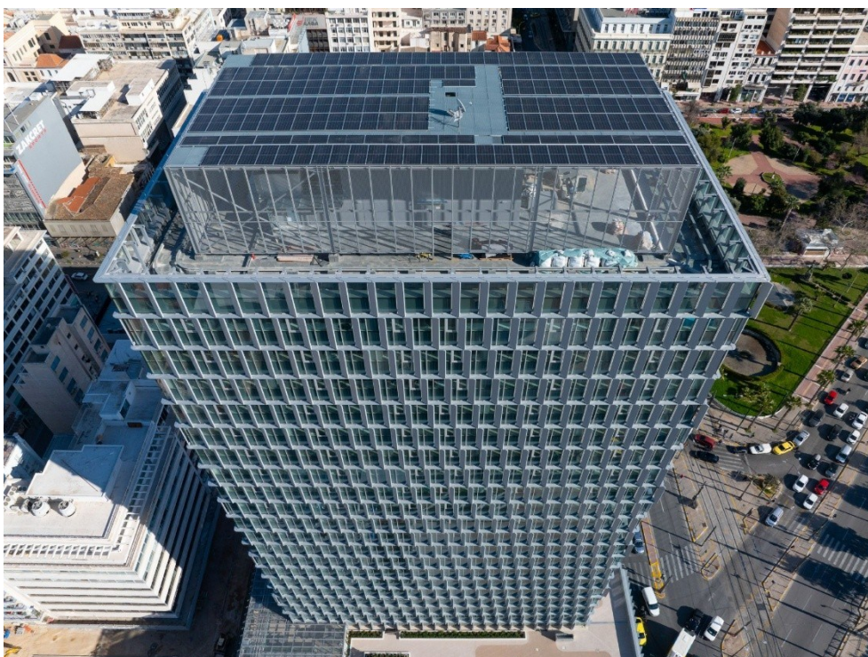
Εικόνα 2.9: Φωτοβολταϊκός σταθμός στο δώμα του Πύργου του Πειραιά ως στοιχείο της στρατηγικής ενεργειακής αναβάθμισης και περιβαλλοντικής πιστοποίησης.
