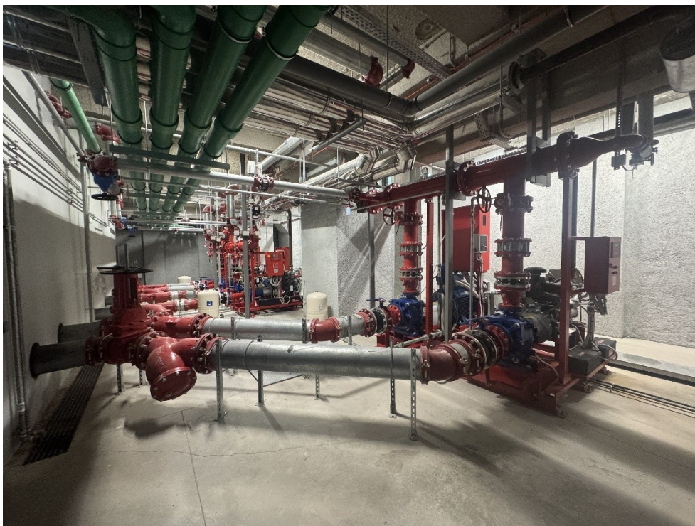
Εικόνα 5.8: Πραγματική άποψη από το αντλιοστάσιο πυρόσβεσης του Β' υπογείου (Σημεία Α και Β). Πηγή: φωτογραφικό/τεχνικό αρχείο έργου, ιδία επεξεργασία.
